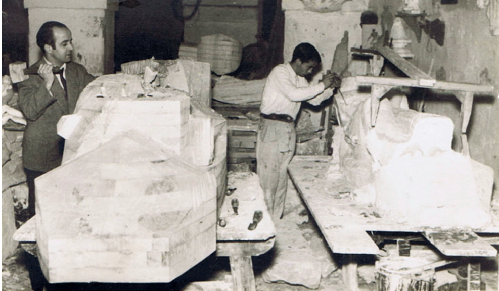
(Figura 9) Proceso de desbaste en madera de la imagen de San Francisco. (Archivo documental de la Fundación Francisco Pinto Barraquero).
