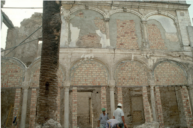
Figura 04. Arquería de la zona habitacional. Imagen de Barrionuevo y Aguilar 2001.
