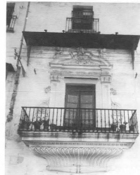
Casa Villapanés. Balcón fachada lateral
