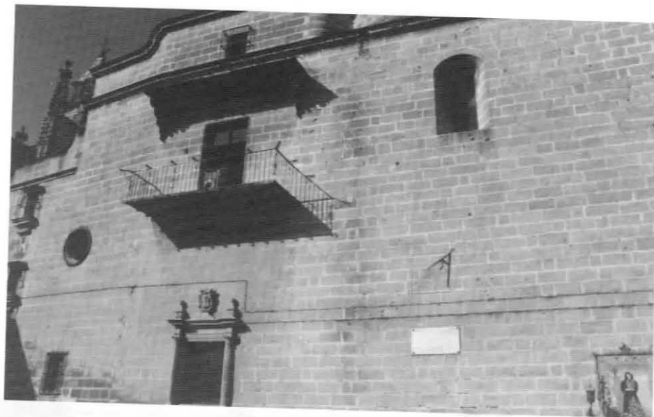
Santiago. Fachada. Hdad. Prendimiento
