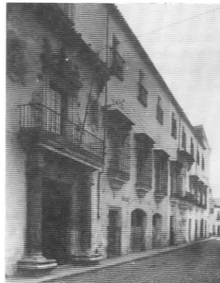
Casa Villapanés. Fachada lateral
