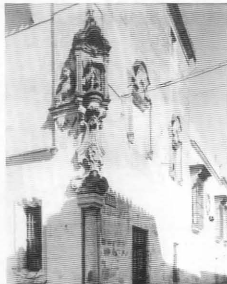
Casa Villapanés. Detalle de la esquina
