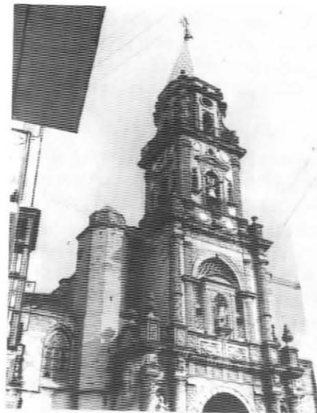
San Miguel. Torre-fachada
