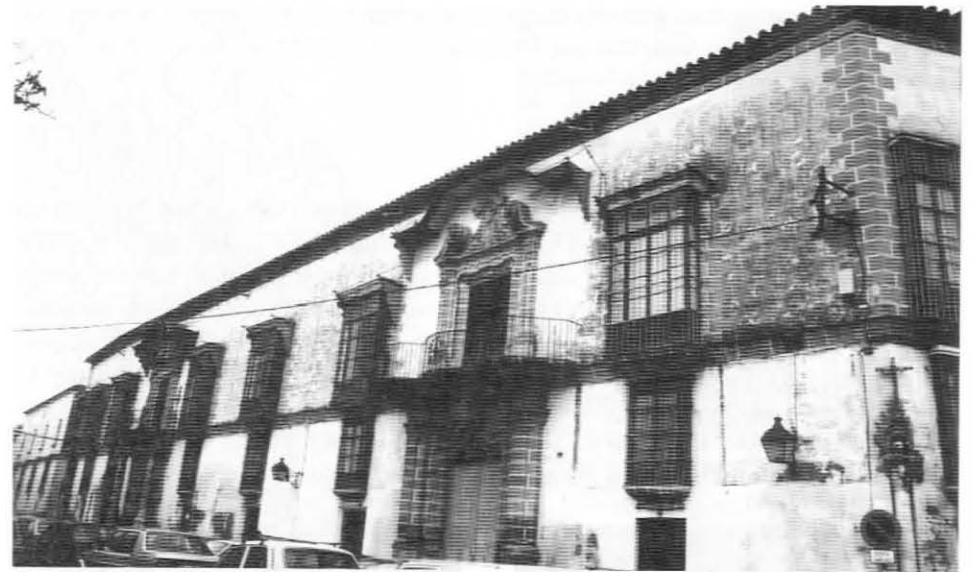
Casa Plaza Domecq n° 51. Panorámica
