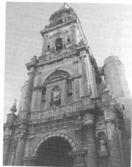
San Miguel. Torre-fachada
