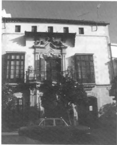
Casa en c/ Corredera, 35. Fachada
