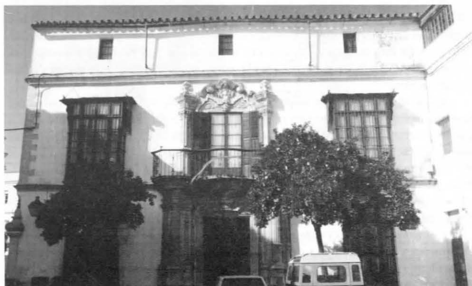
Casa Plaza Rivero nº 4. Fachada principal
