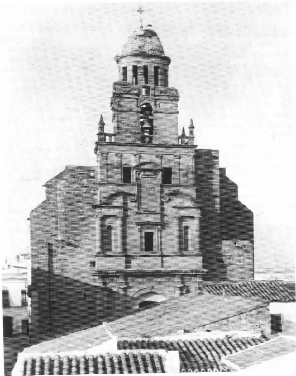
San Juan. Torre-fachada
