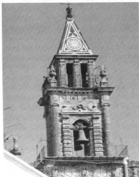
Santiago. Pormenor de la torre
