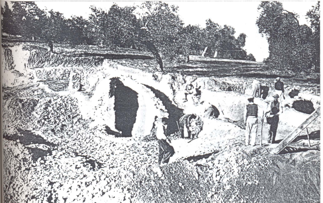
Figura 2. a Las excavaciones al finalizar la exploración del «amplivium».
