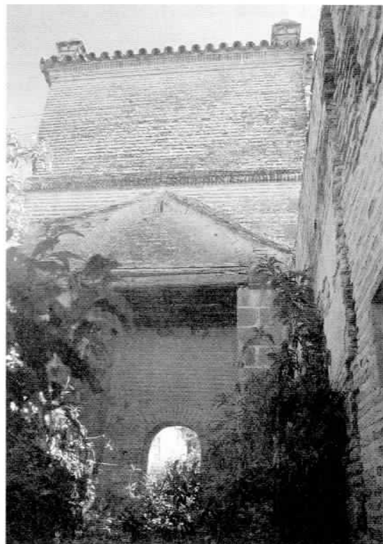
Foto 4.- Interior de la torre de contrapeso del molino de La Cartuja. "Capilla" de una de las naves de prensa.
