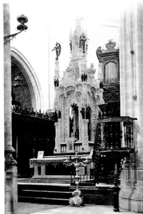
7. Vista lateral del presbiterio de la iglesia de Santiago tras la instalación del altar-templete de Gallegos y Arrosa.
