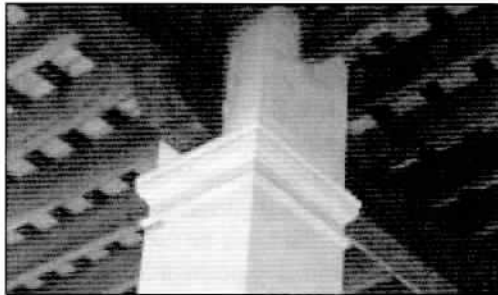
Detalle del pilar y del forjado
