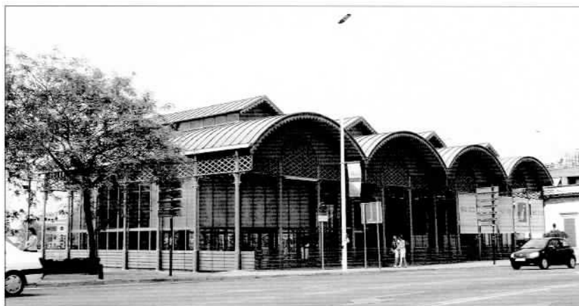
3 - Mercado del Barranco (Sevilla), imagen actual. Mercado para venta de pescados, diseñado en 1876 y construido en 1883 por la fundación "Hermanos Portilla y White". Junto con "La Concha" representa uno de los primitivos ejemplos de arquitectura del hierro en Andalucía.
