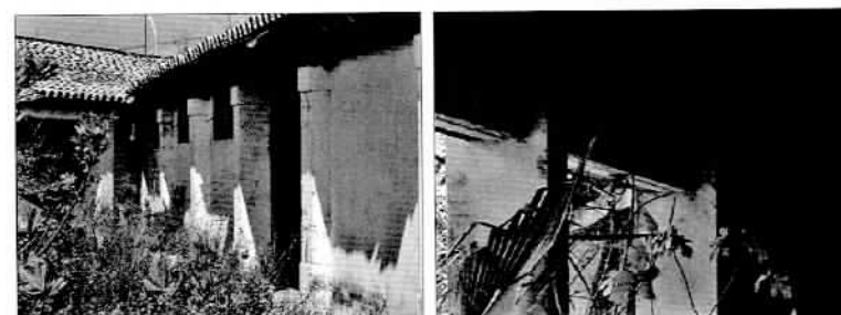
Detalles de las galerías del patio.
