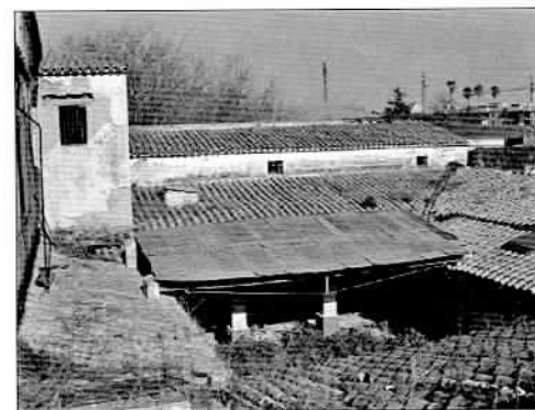
Cubierta de la galería
