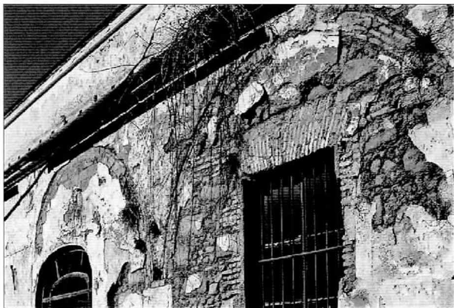
Det. Arcos de descarga en fachada
