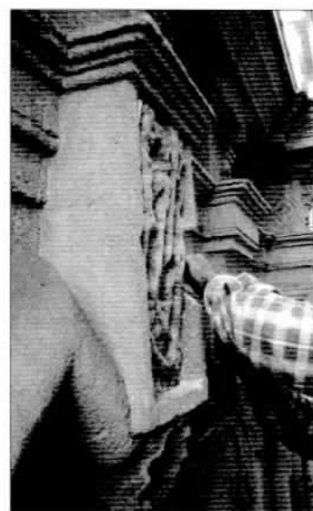
Fot. 04 - Procedimiento de extracción de la obra, la superficie del relieve se protegió con un engasado rígido.
