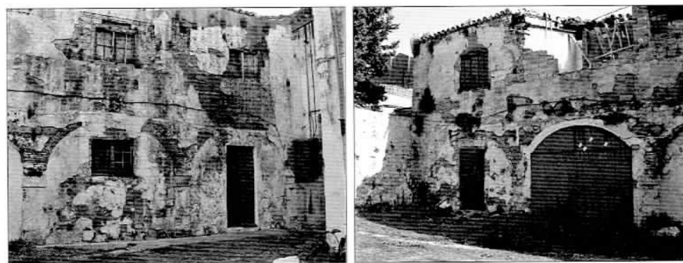
Det. Fachada del edificio
