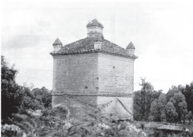
Foto 3.- Torre de contrapeso del molino de aceite del monasterio de La Cartuja de Jerez.
