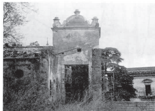
Foto 2.- Torre del molino del Alcázar. Nave de prensa que se desarrolló con fachada al solar del antiguo teatro Eslava. Estado inicial en el momento de acometer los trabajos de investigación. Al fondo bajo la torre de contrapeso se abre la "capilla". A mano izquierda edificación correspondiente a la sala de molienda.
