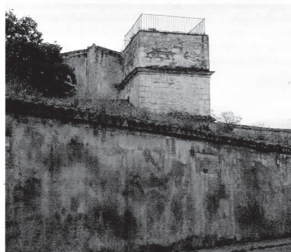
Foto 6.- Torre de contrapeso del molino de aceite del antiguo convento de La Merced. Vista exterior desde la C/ Armas de Santiago. La parte superior se ha modificado para aprovecharla como mirador.
