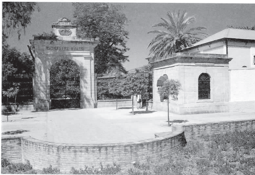
Puerta y Pabellón de entrada principal a las bodegas, construidos por Agustín García Ruiz en 1863. Otro pabellón flanqueaba el arco de entrada, pero fue demolido. La fecha de 1835 que reza en el arco triunfal de entrada no corresponde con el año de su construcción, sino con la fecha de inicio de la actividad bodeguera de D. Manuel González Peña, uno de los principales socios de la compañía vinatera.
